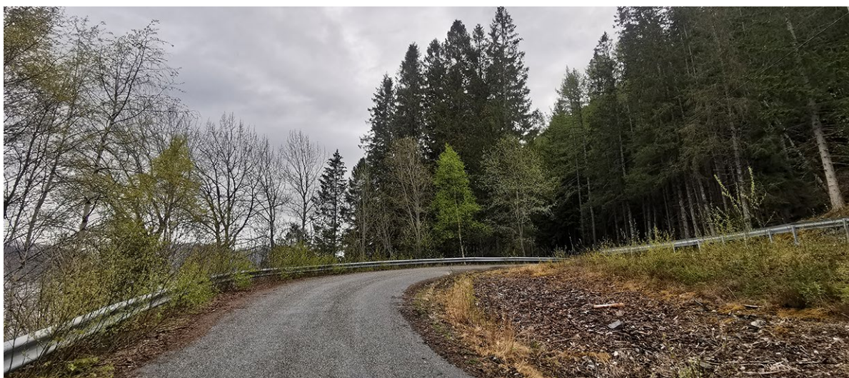
Figur 13: Selv om den største, mest skjermende vegetasjonen tas vekk, vil eksisterende, lavere vegetasjon nedenfor utgjøre en skjerming mot fjorden. Skjerminga vil bli kraftigere med tiden etter hvert som den vokser til og suppleres med ny vegetasjon.
