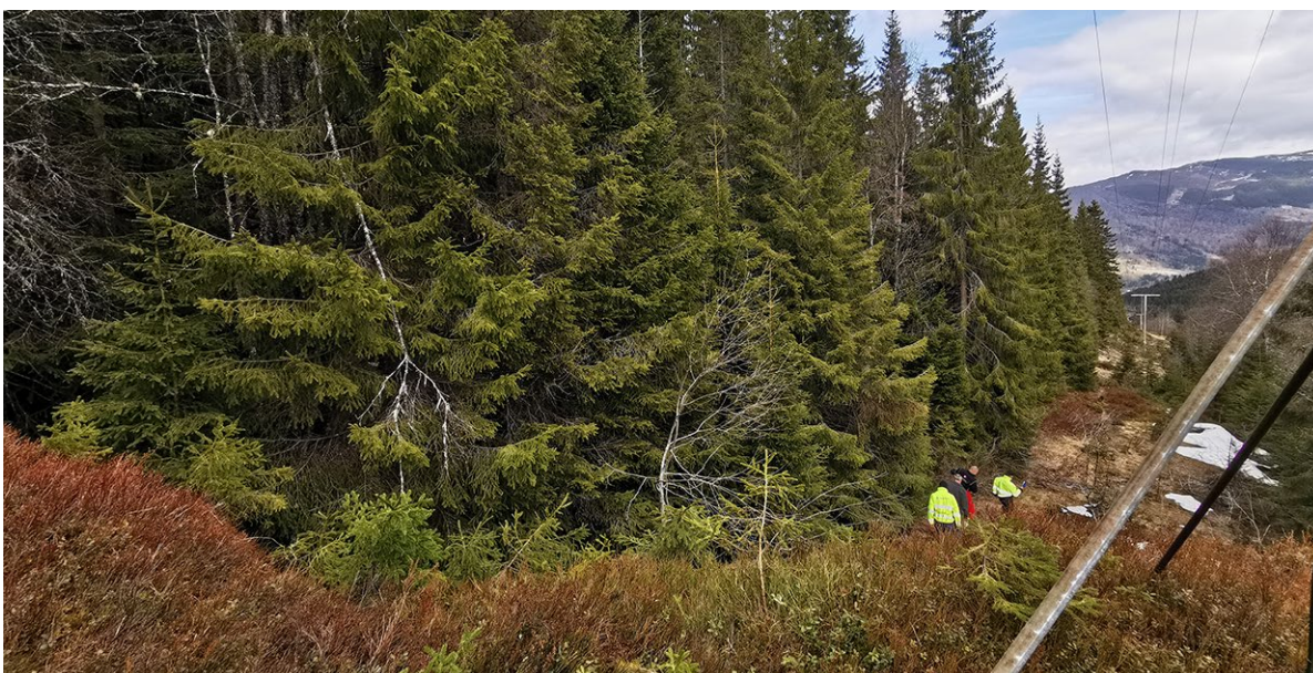
Figur 27: Bilde tatt fra terrengform som avgrenser deponiet mot vest. Formen gir rom for å legge masser inn mot terrenget, som muliggjør en god dybde i deponiets ytterkant. Tilsvarende vil være tilfelle i bakkant av deponiet der terrenget også er påtagende. Kraftledningstraseen vil definere avgrensingen mot sør, som helst skal ha en minimumsavstand fra ledningene på 30 meter i horisontalplanet.
